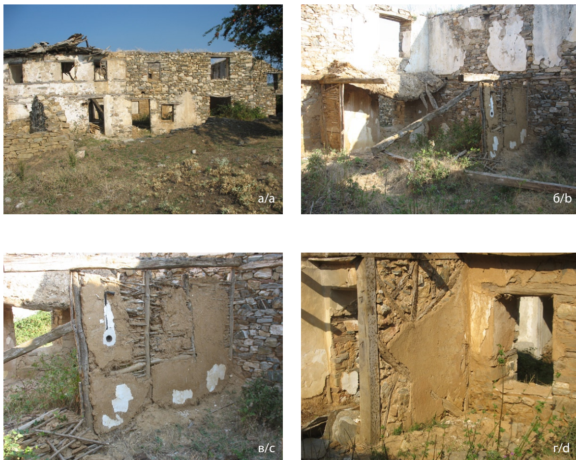
Обр. 9. Масивна каменна сграда, изоставена през 80-те години на XX век (Източни Родопи): а. общ изглед отвън; б. останки от вътрешни преградни стени; в. преградна стена с колово-плетена конструкция (детайл); г. вътрешна преградна стена (детайл).
